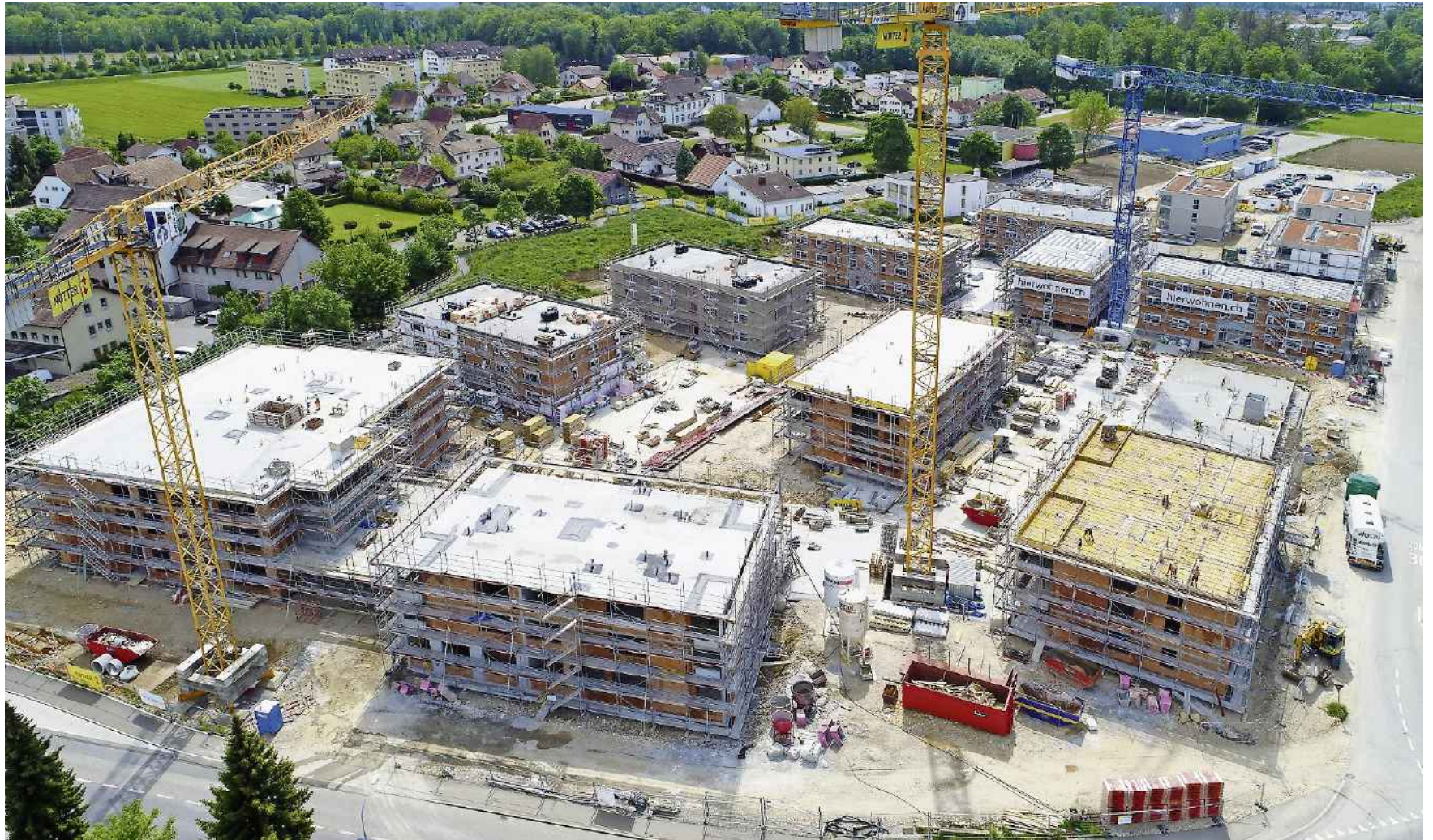
Am 1. April 2020 soll die Seniorenresidenz (vorne links im Bild) eröffnet werden. Die Mehrfamilienhäuser sollen auch im Frühjahr fertig werden.
